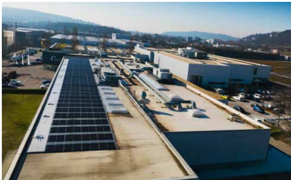
Fotovoltaika na střeše společnosti WALTER v Tübingenu.
